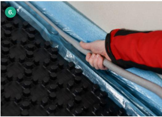
Fixierung des Folienflansches der Randdämmstreifen mit PE-Dichtprofil in der äußeren Noppenreihe.
