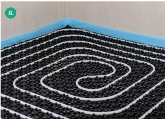
Fertig verlegte Noppenfläche mit schneckenförmig angeordneten Heizrohren.
