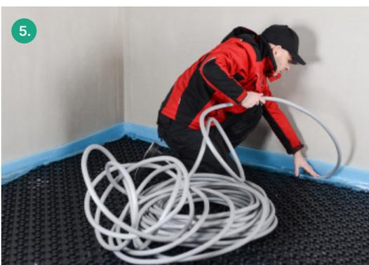
Bei Einsatz von Fließestrichen sind die Ränder mit dem Folienflansch der Randdämmstreifen abzudichten. Dabei wird der Flansch in der äußeren Reihe der Noppen mit Heizrohr oder PE-Dichtprofil fixiert.
