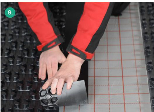
Türdurchgänge, Verteiler- und Dehnfugenbereiche können mit EPS (Rollbahn / Falplatte) hergestellt werden.
