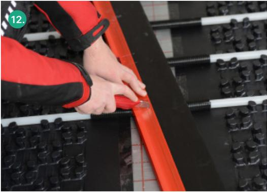
Das Dehnfugenprofil wird entsprechend der Rohrabstände ausgeschnitten.
