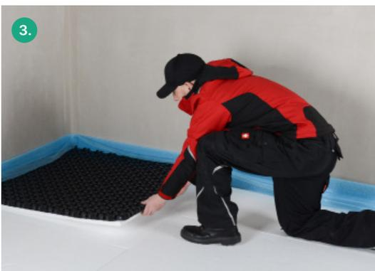
Schnelle Verlegung durch großformatige Noppenplatten, die eine Ein-Mann-Rohrverlegung ermöglichen. Mit der Verlegung wird in einer Raumecke begonnen, sie ist wandbündig mit dem Folienüberstand nach innen.
