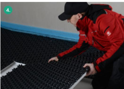
Die Noppenplatten haben 2-seitig übereck stehende Noppenreihen (Folienüberstand) zur Druckknopfverbindung der Noppenplatten. Die letzte Platte wird entsprechend des Raumes angepasst und verlegt. Mit der Restplatte können Sie die Verlegung der nächsten Reihe beginnen.
